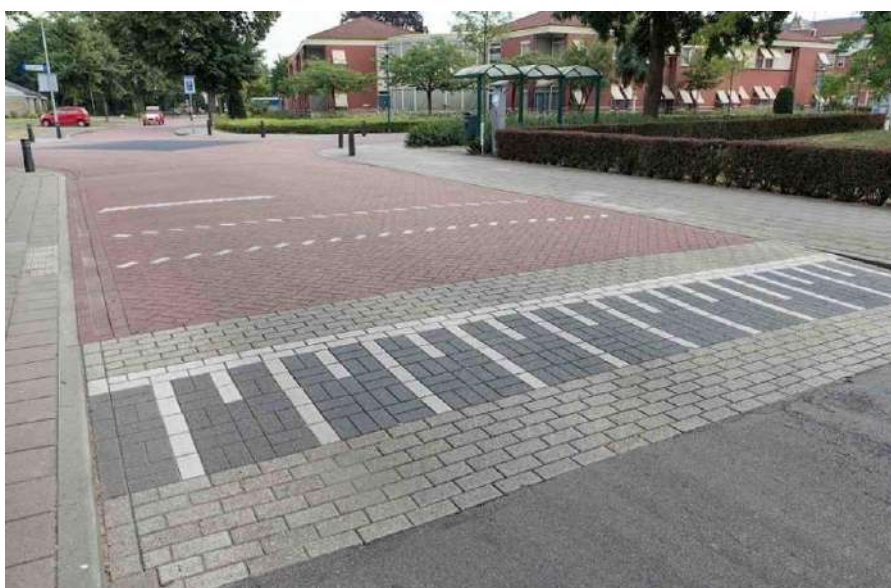
Рисунок 13. Пример приподнятого пересечения
