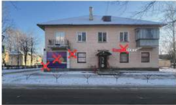
Баннер на фасаде Вывеска размещена без соблюдения отступа от окна Фрагментная отделка фасада Хаотично расположенное на фасаде оборудование
