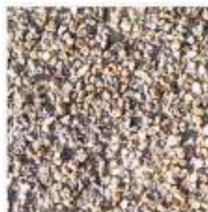
Набивное покрытие дорожек
