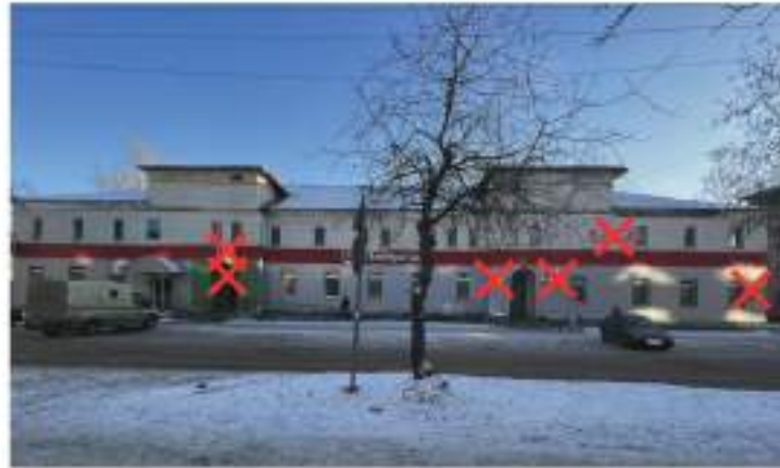
Баннеры на фасаде Логотип и вывеска превышают высоту фриза Фрагментная отделка фасада
